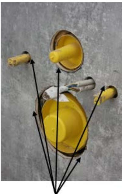
Hohlräume mit Supergrip Xtrem H 751 auffüllen und abdichten, gegebenenfalls mit Plattenabschnitten hinterlegen
