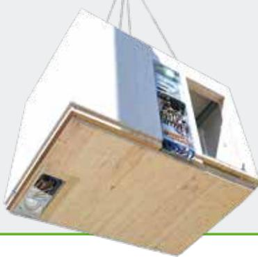
Die bis ins letzte Detail vorgefertigten Raummodule beinhalten die kompletten haustechnischen Installationen sowie das hochwertig ausgestattete Badezimmer. Sämtliche Wohnungsverteiler und Anschlüsse befinden sich leicht zugänglich im sogenannten Kombi-Hybrid-Verteiler direkt neben der b\_box Eingangstür.
