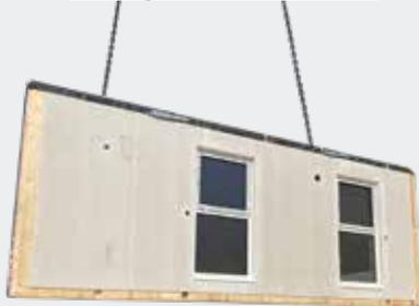
Die hochgradig industriell vorgefertigten Fertigteilwände, sogenannte Flatpacks, bieten ausreichend Spielraum für individuelle Planung. Die Breite und Höhe der Wände und auch die Position der Fenster- und Türöffnungen sind individuell wählbar.
