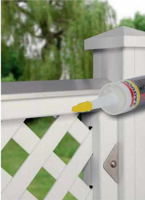
Designaufsatz Alu mit MS-Polymer-Kleber (1398) befestigen.
