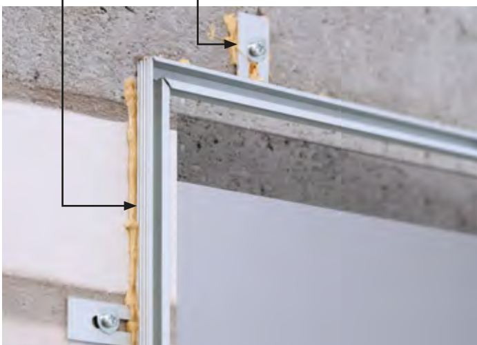
1. Putzprofil mit Befestigungslaschen auf der Wand montiert
