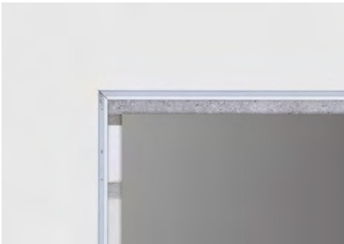
3. Fertiggestellte Wandoberfläche mit überdecktem Putzprofil
