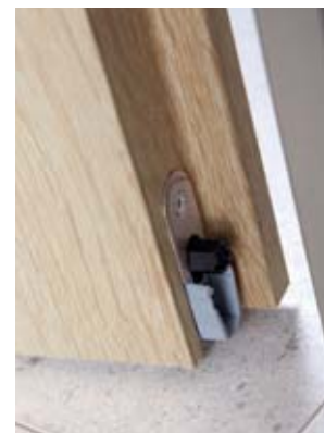
Standardausstattung bei Schallschutztüren: mechanisch absenkbare Bodendichtung
