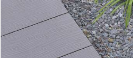
nach Reinigung mit Wasser
