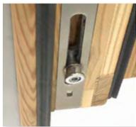
Wie auch bei den Fenstern ist die Basissicherheit bereits integriert und kann bis Klasse RC1N ganz einfach ausgebaut werden. Wer mehr Sicherheit sucht, der kann bei PAS in genormter Sicherheit bis Klasse RC2N nach EN1627 aufrüsten.
